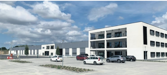
Dansk Halentreprise har blandt andet opført et stort, samlet anlæg for transportvirksomheden SCT i Allerød med hovedadministration, smedeværksted, serviceværksted, synshal, dækcenter, vaskehal, reservedels-ekspedition og velfærdsfaciliteter. Foto: SCT
