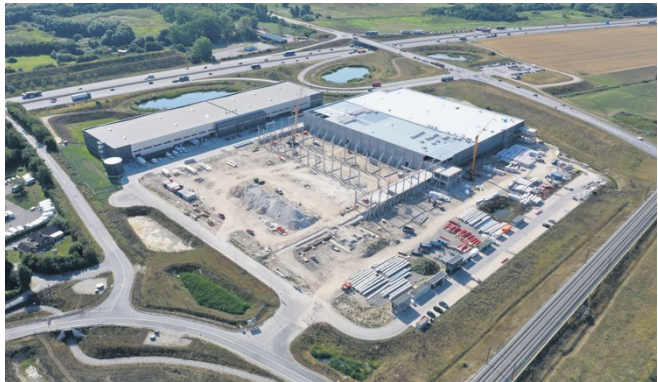
Dansk Halentreprise har i år leveret 55.000 kvadratmeter logistikcenter i Solrød til Verdion. Foto: Dansk Halentreprise
